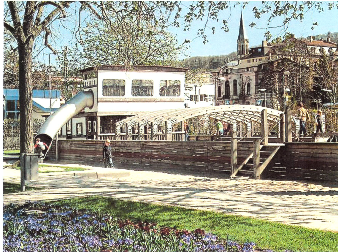
Hat eine Renovierung nötig: das Spielschiff in den Rheinanlagen.
